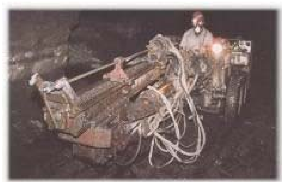
FIGURA 5. Trabalho de perfuração no interior da mina.
