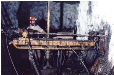
FIGURA 3. Procedimento de sondagem.
